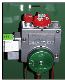
THERMOSTAT Automaticky kontroluje teplotu plynu. Manuálně nastavitelný.
